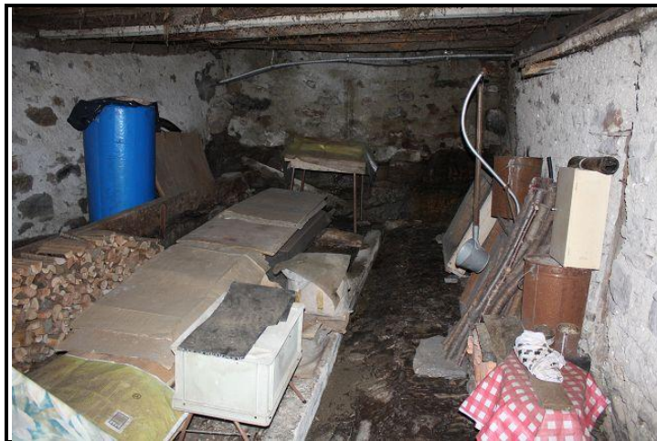
Locale PT / Raum im Erdgeschoss
