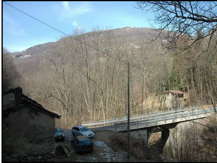
Vista verso ovest / Westblick
