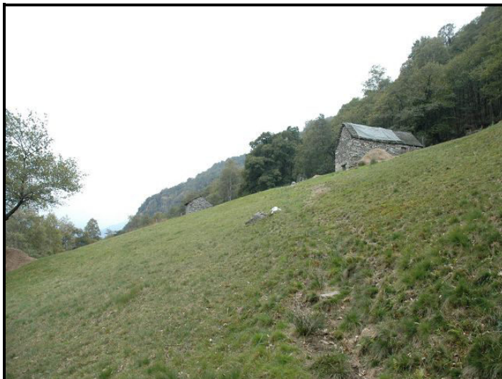
Vista da sotto / Blick von unten
