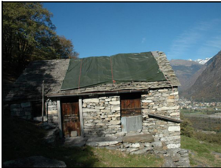
Facciata sud / Südfassade
