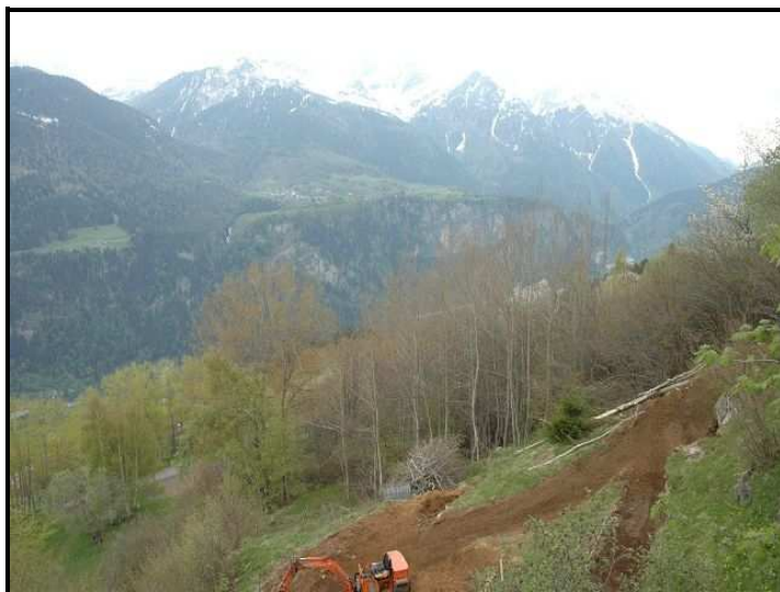
Vista verso nord-ovest / Blick nach Nord-Westen
