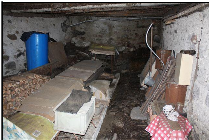
Locale PT / Raum im Erdgeschoss
