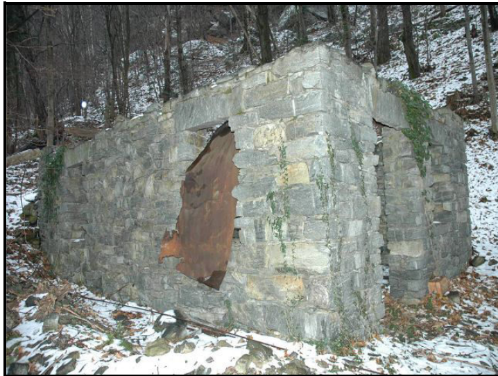
Facciata ovest / Westfassade
