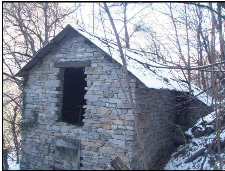
Facciata sud / Südfassade
