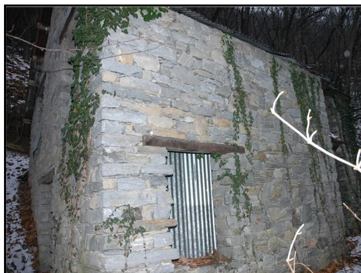
Facciata ovest / Westfassade
