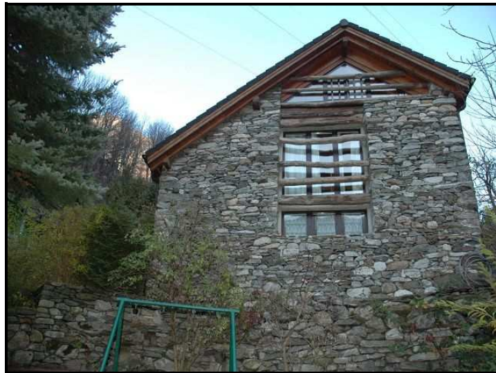
Facciata sud / Südfassade
