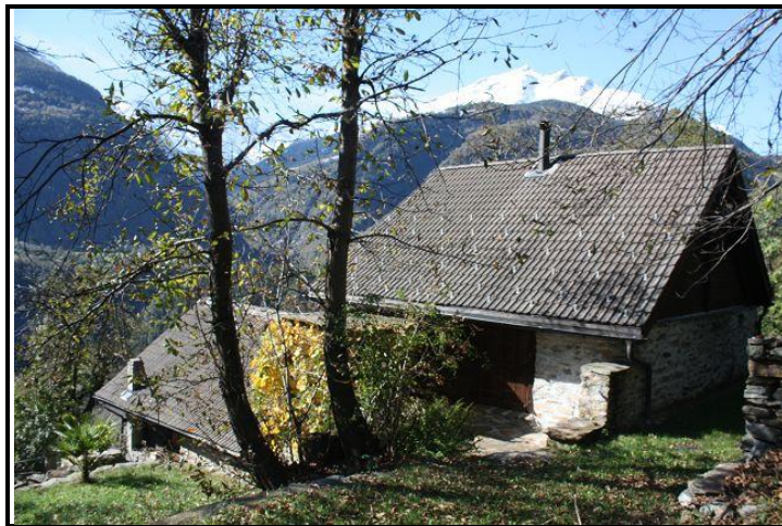
Vista verso ovest / Westblick
