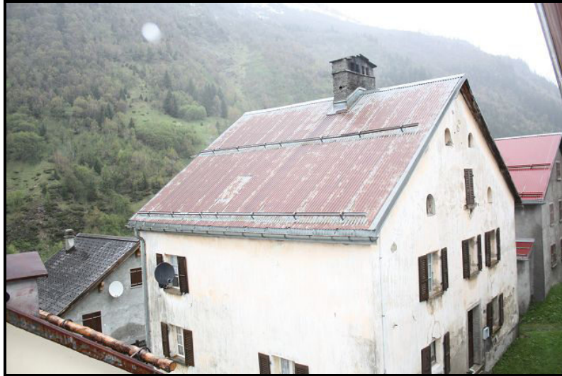
Vista nord-est / Nordostblick
