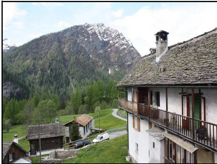
Vista sud/ Südblick
