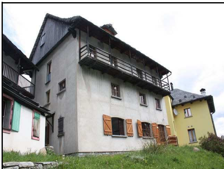
Facciata sud / Südfassade
