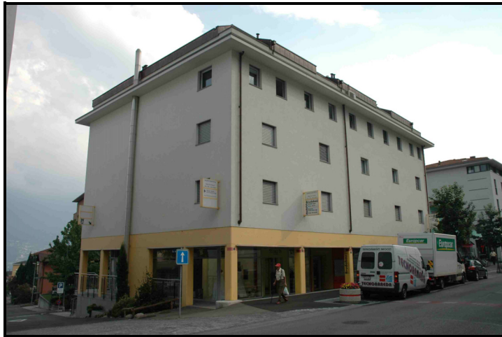
Facciata nord con entrata / Nordfassade mit Eingang
