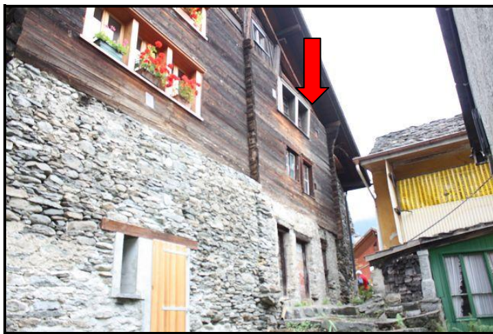
Facciata sud / Südfassade
