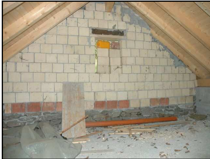
Sotto tetto / Dachraum
