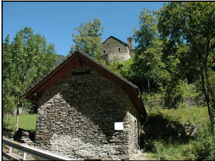
Facciata ovest / Westfassade
