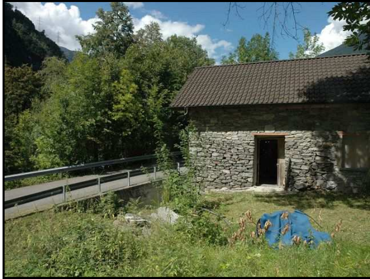
Parte sud / Südteil der Liegenschaft
