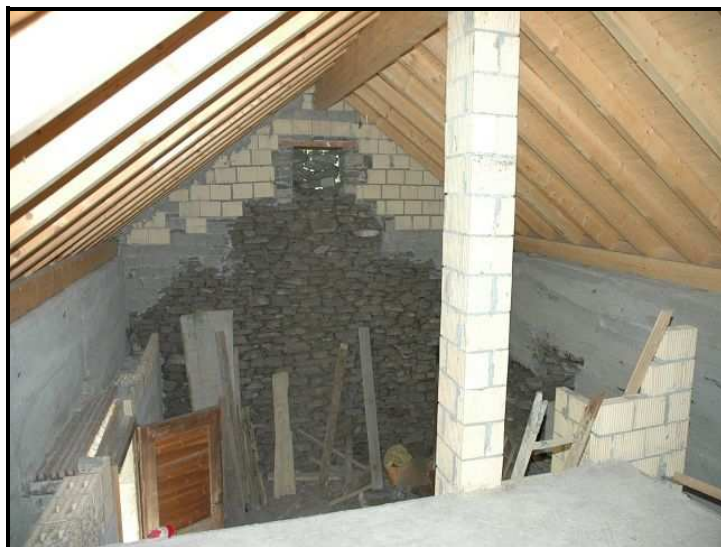
Vista da sopra / Blick vom Dachraum
