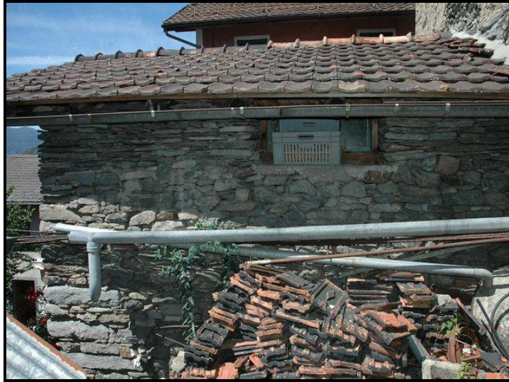
Facciata est / Ostfassade
