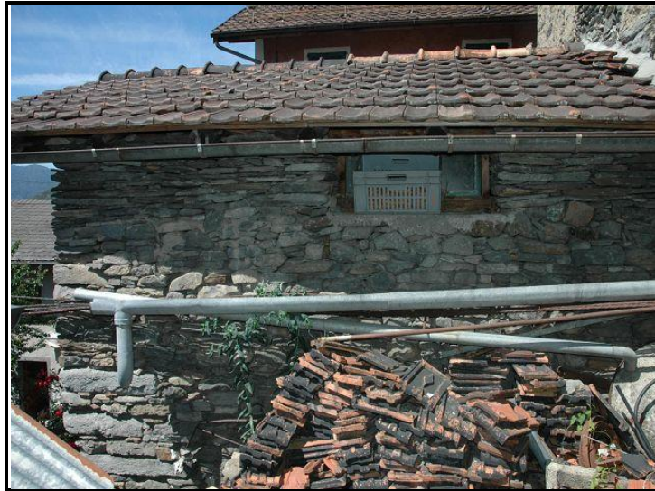
Facciata est / Ostfassade
