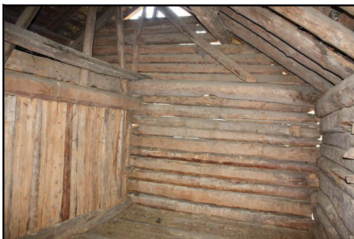
Parte sopra / Dachgeschoss
