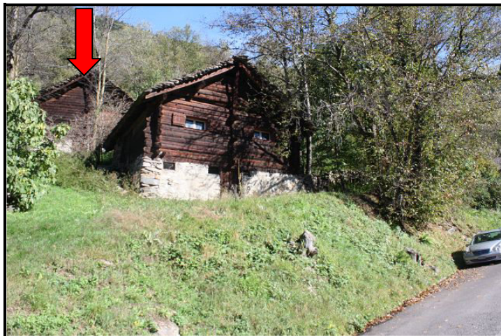
Vista da sotto verso rustico / Blick von unten auf Rustico
