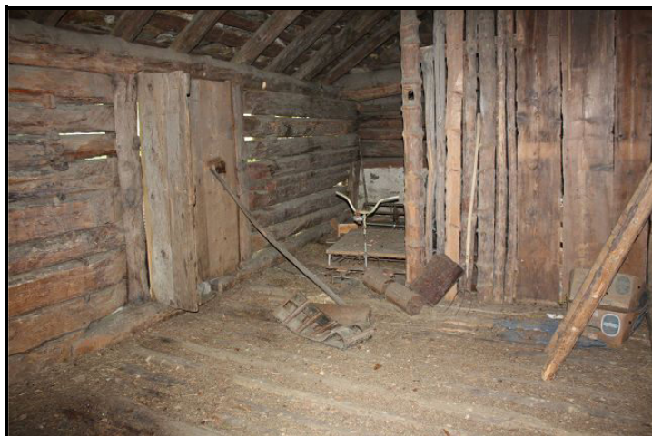
Parte sopra / Dachgeschoss
