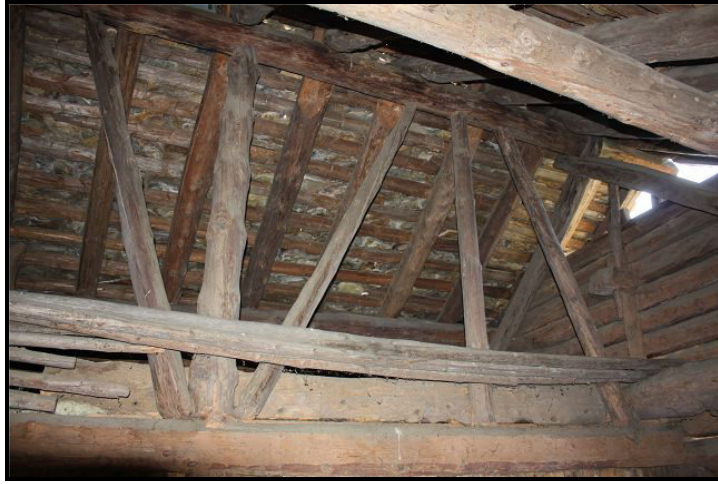
Solaio / ungebauter Dachraum
