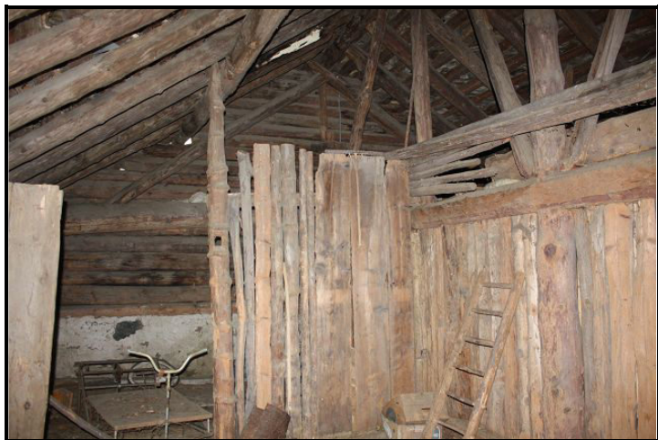
Parte sopra / Dachgeschoss
