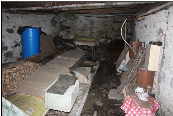
Locale PT / Raum im Erdgeschoss
