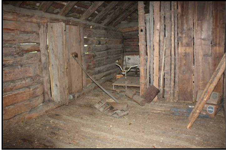
Parte sopra / Dachgeschoss
