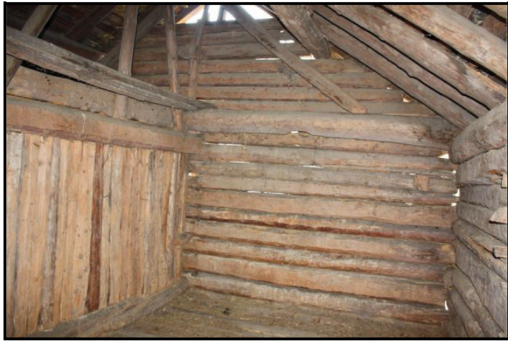
Parte sopra / Dachgeschoss
