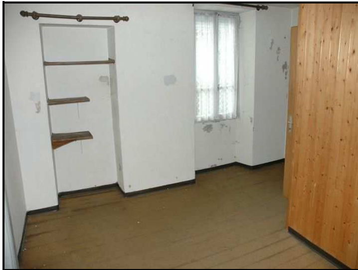
Camera con doccia / Zimmer mit Dusche
