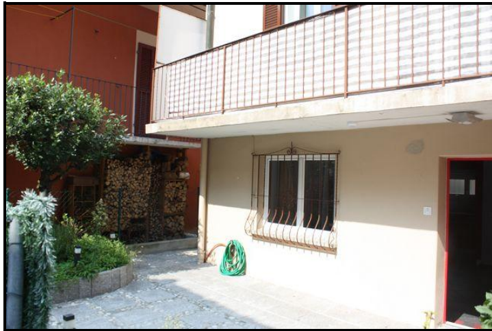
Cortile e balcone / Hof und Balkon
