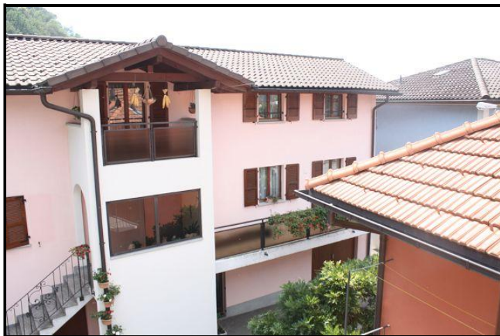
Vista sud / Südblick
