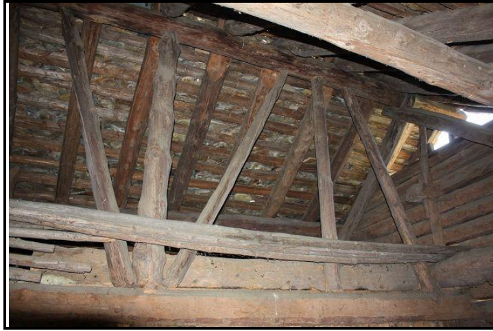
Solaio / unausgebauter Dachraum
