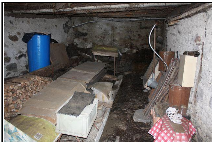
Locale PT / Raum im Erdgeschoss
