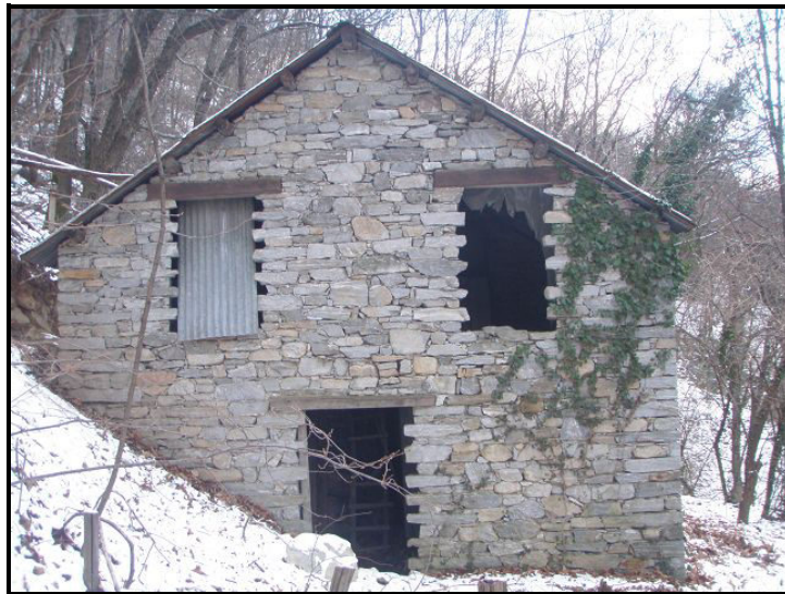
Facciata nord / Nordfassade
