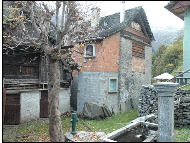
Facciata nord / Nordfassade
