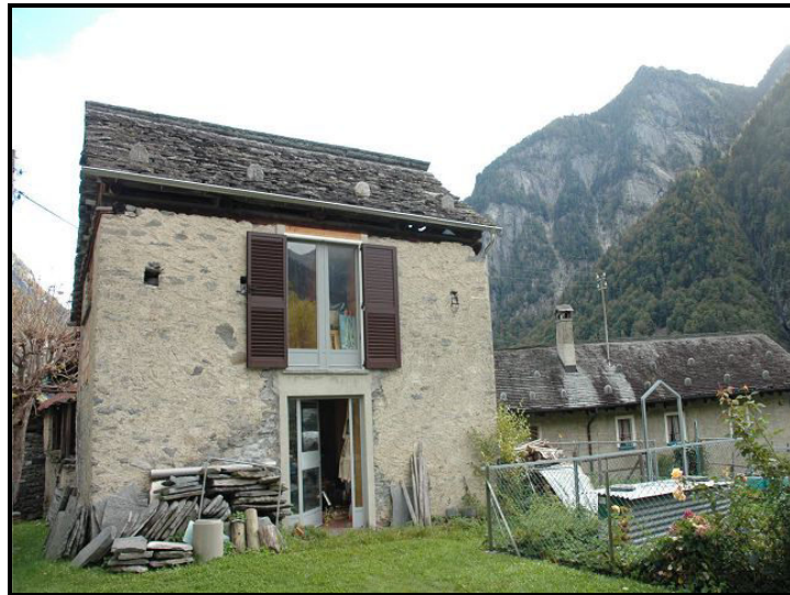
Facciata ovest / Westfassade
