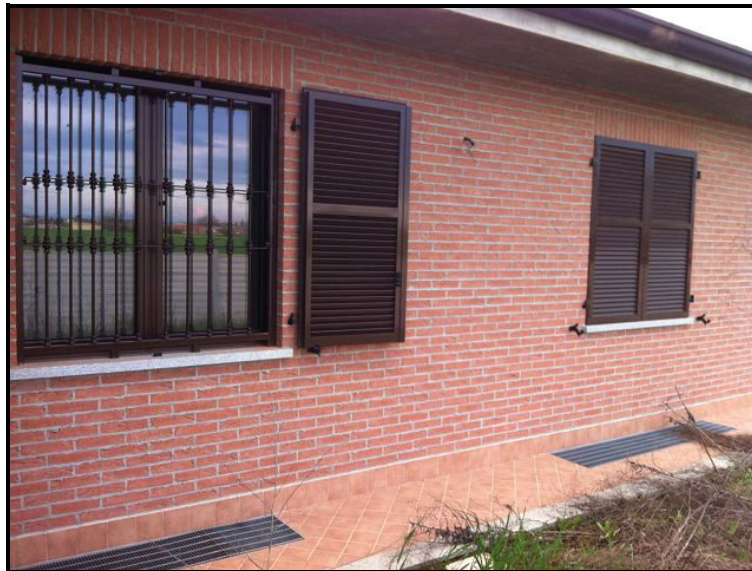
Lato ovest con marciapiede, mattoni a vista ed infissi / Westfassade
