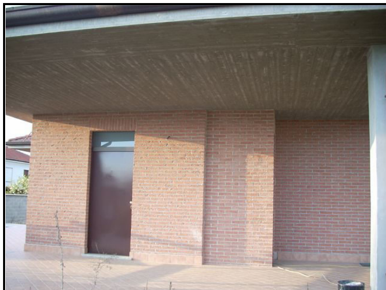
Un'altra vista dell'ingresso / Eingang
