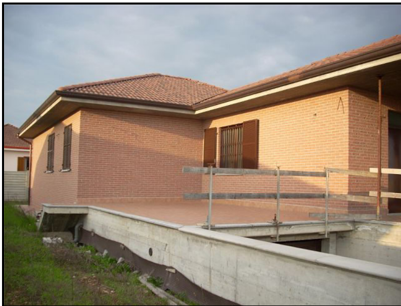
Lato est con il balcone che copre la rampa di accesso ai garage / Haus
