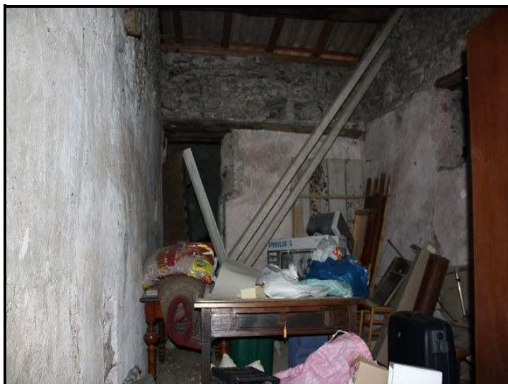
Sotto tetto / Dachraum
