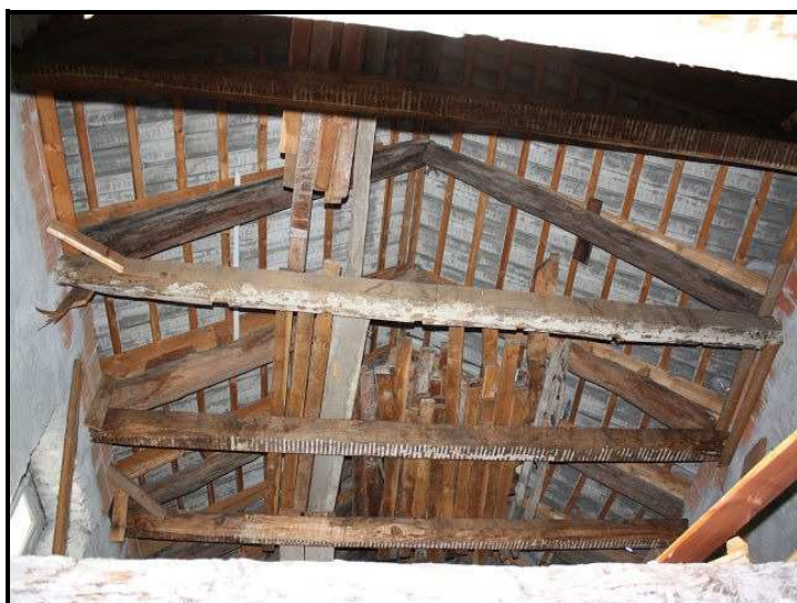
Sotto tetto / Dachstock
