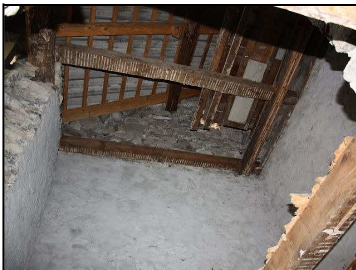
Sotto tetto del bagno / Dachuntersucht beim Bad
