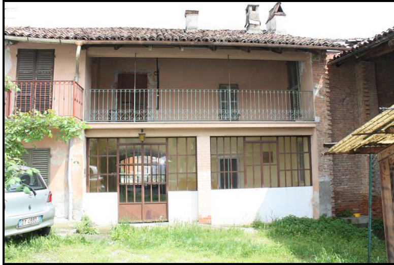
Facciata ovest / Westfassade
