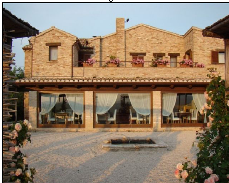
Sala ristorante con veranda
