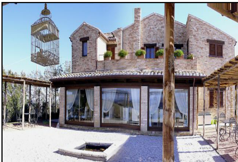
Vista del ristorante – pergola
