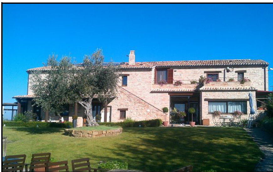
Casolare, vista dell'appartamento padronale
