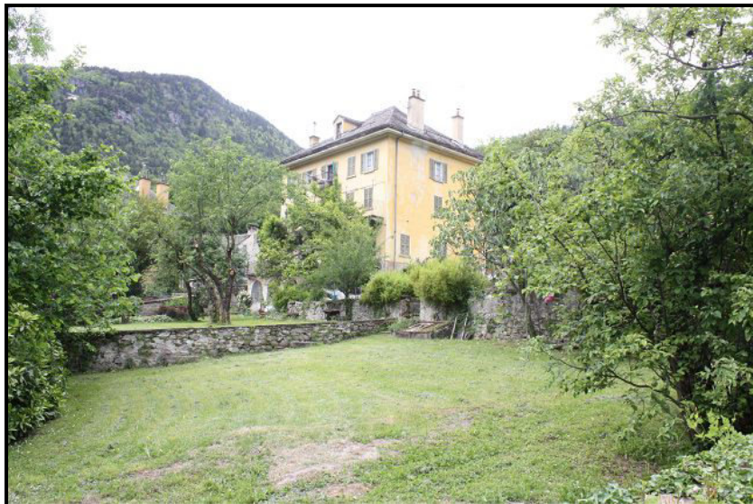
Facciata est / Ostfassade
