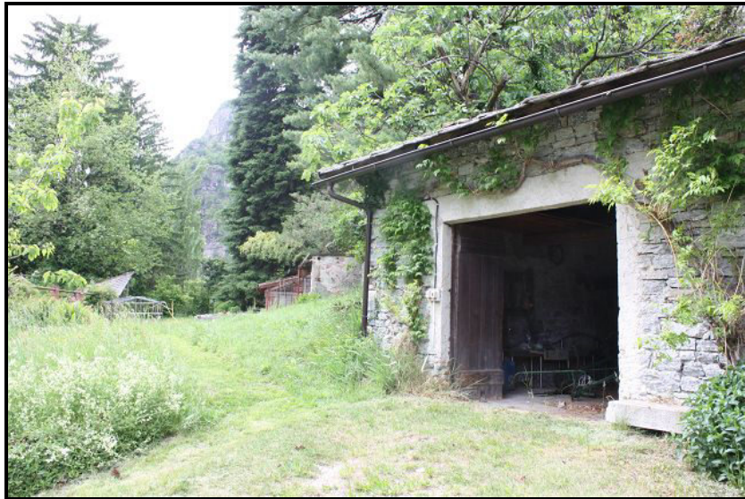
Facciata ovest / Westfassade
