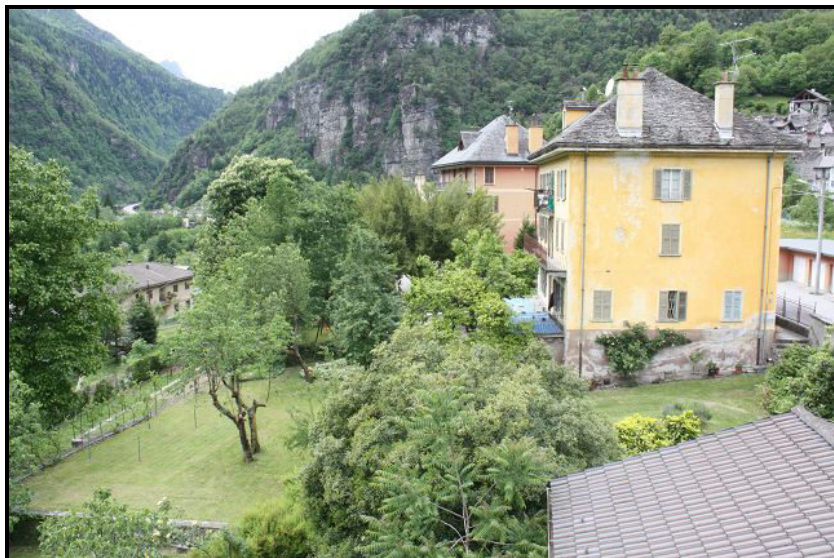
Vista sud / Südblick
