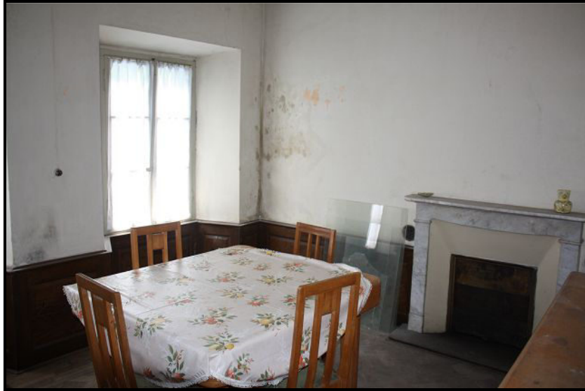
Vista sud-est / Südostblick
