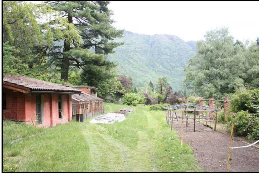
Vista sud-est / Südostblick
